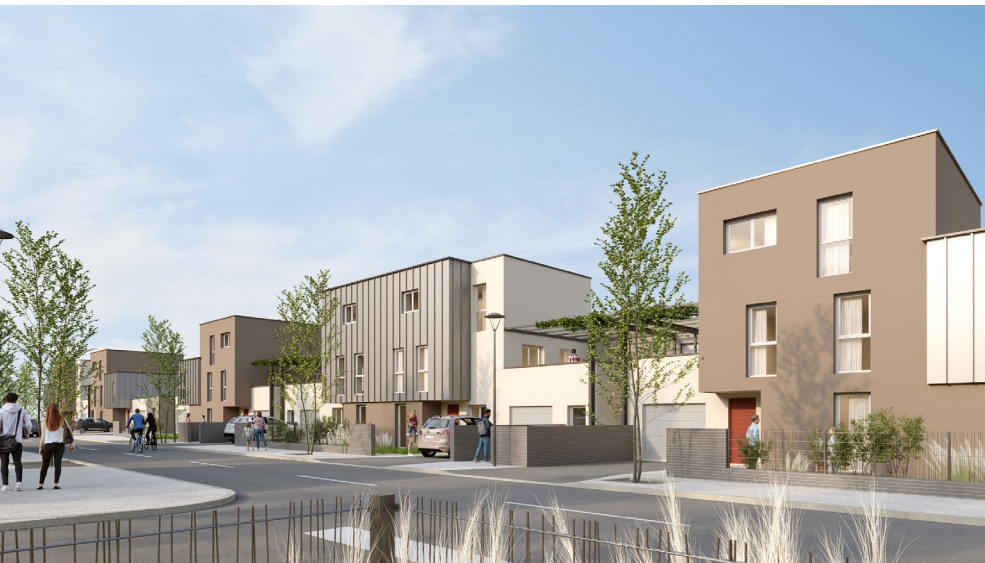
217 logements - Espace Grandry - Charleville-Mézières
