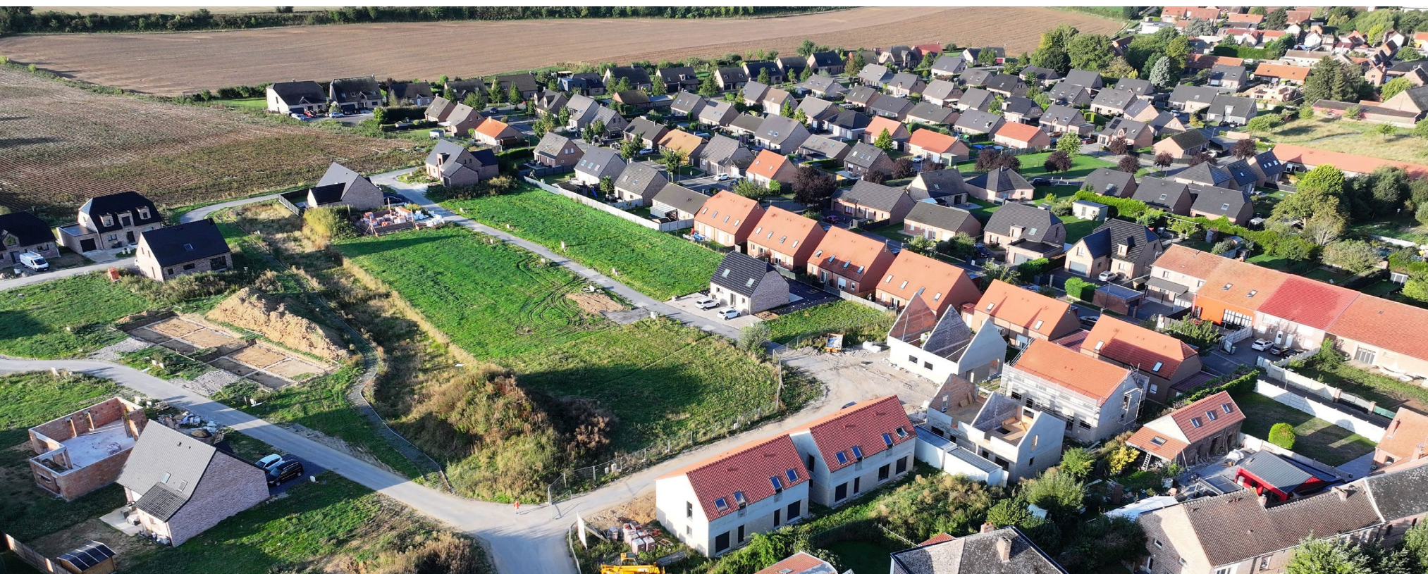
Saultain 115 maisons en cours de construction
